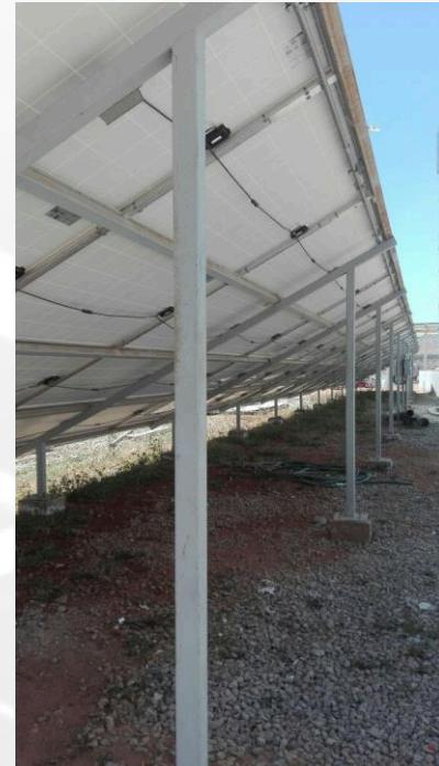
Sistema solar para interconexión a red pública, propuesta por **\$1.80/kw** instalado, considerando 12 secciones de 16 módulos, generando un total de **192 MÓDULOS** de **325** watts c/u, para una generación diaria de 340,704 Wh.
